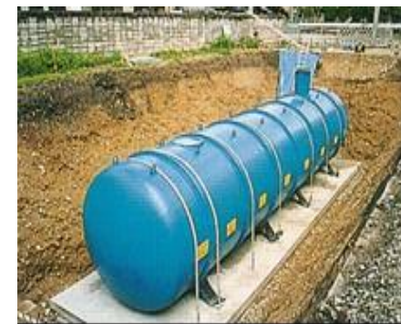
【耐震性貯水槽】
